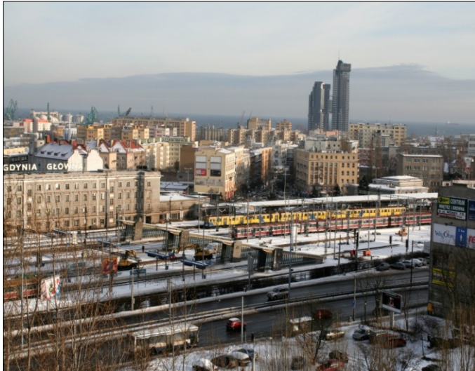
(Zdjęcie pozyskano w ramach kontroli NIK)
